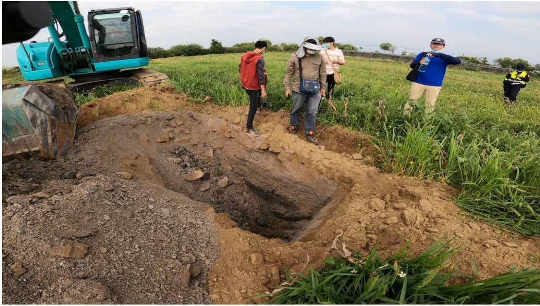
多處點位開挖後深達 5 米
