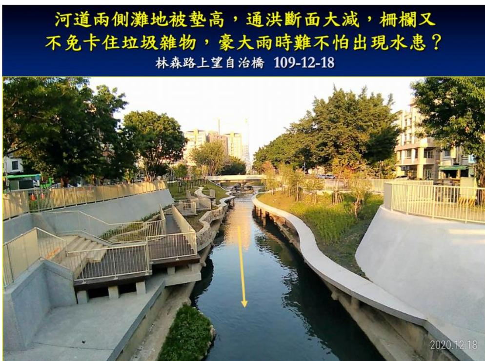
圖 4：河道兩側灘地被墊高，通洪斷面大減，柵欄又不免卡住垃圾雜物，豪大雨時難不怕出現水患？林森路上望自治橋，攝於 109 年 12 月 18 日（張豐年攝）。
