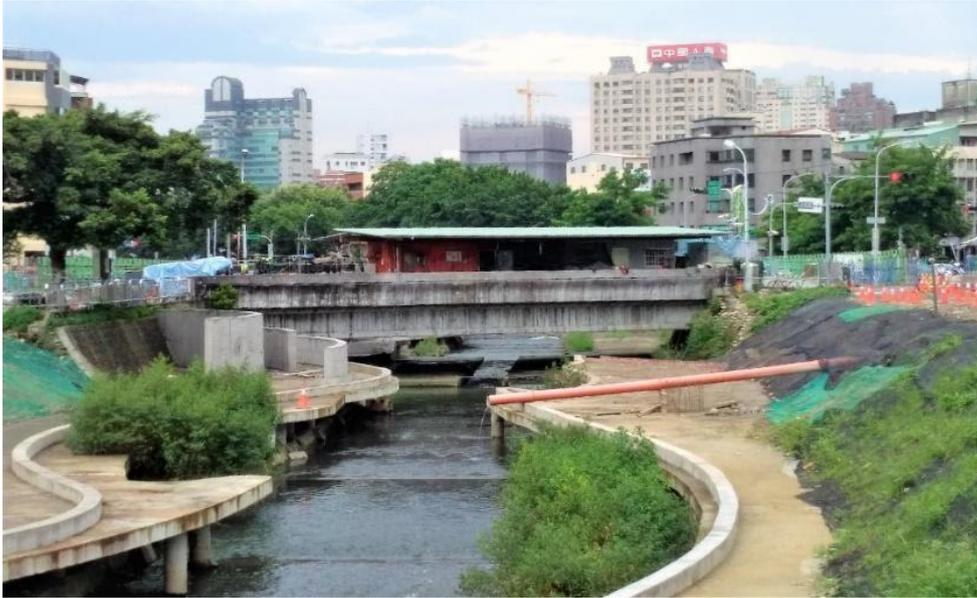
圖 5：金山有橋不僅橋孔過於狹窄，人行步道又墊高河床，豪大雨時水流不免受阻，潛伏水患危機，攝於 108 年 8 月 25 日（張豐年攝）。
