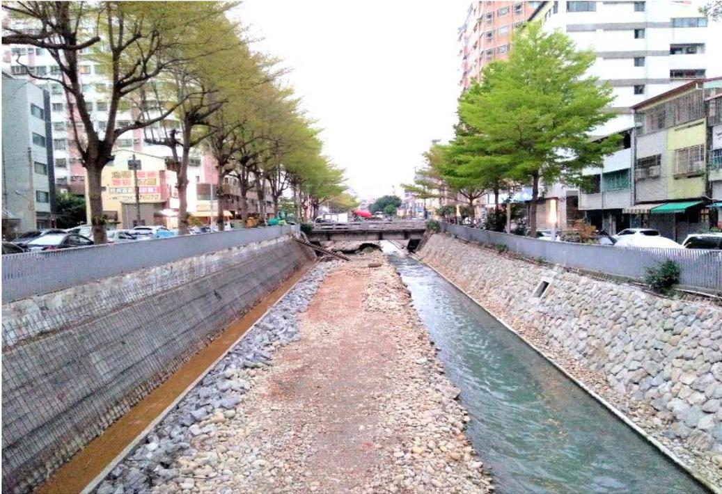
圖 8：人一橋之橋孔極為狹窄，在兩側護岸另加上漿砌石，不免縮小通洪斷面，難不怕日後周遭反出現水患？復新路上望，攝於 109 年 3 月 11 日（張豐年攝）。
